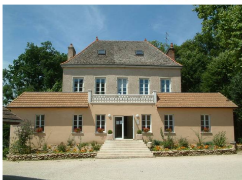
Bâtiment administratif - accueil
